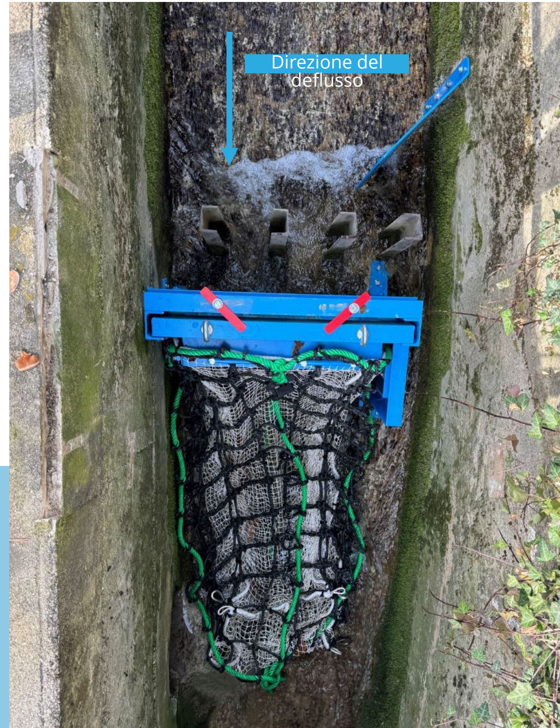
Ritenzione di materiali ingombranti per impedire l'immissione di detriti e l'intasamento della rete idrica sotterranea situata a valle - Lonay, Vaud
