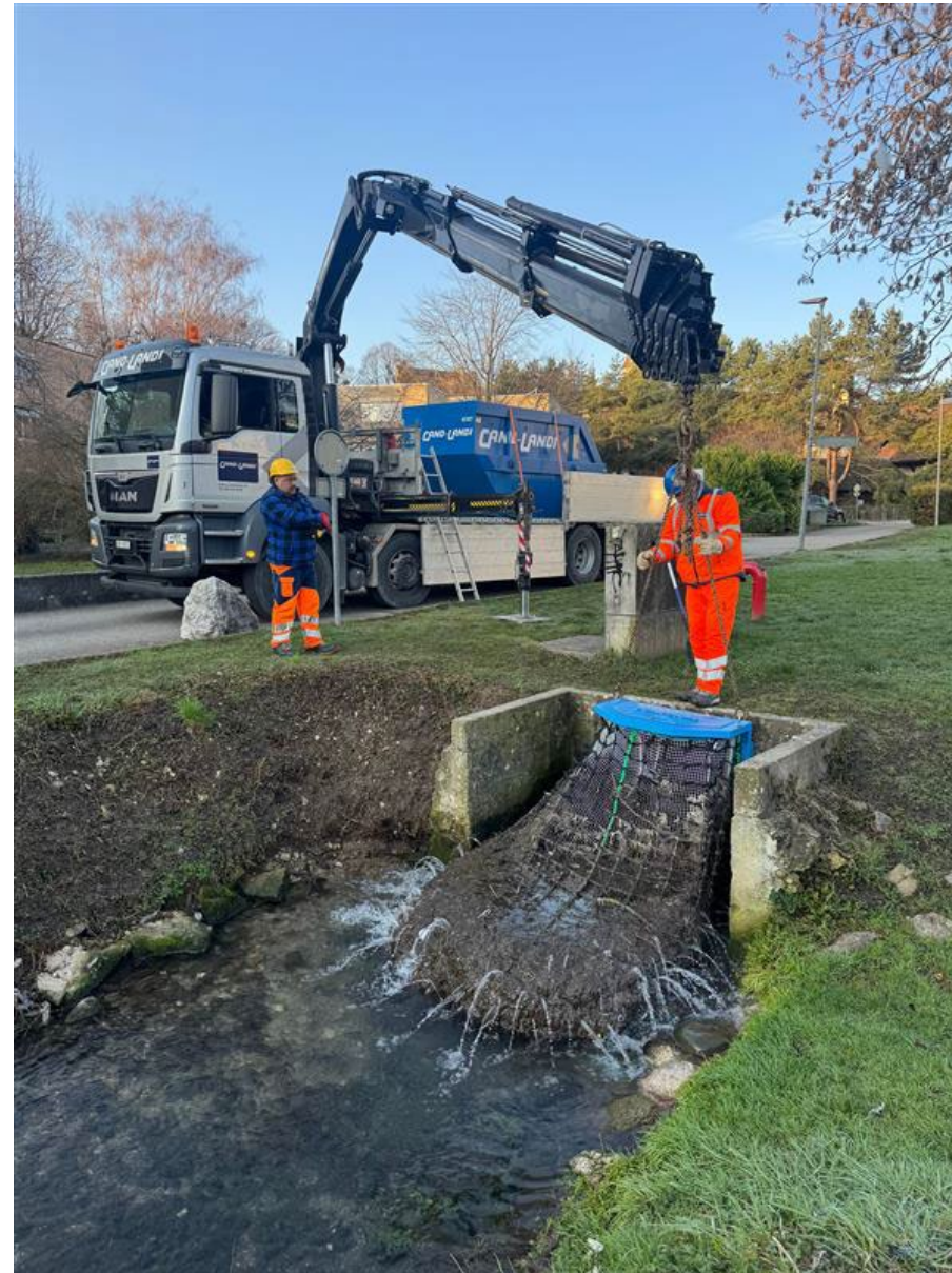
SVUOTAMENTO MEDIANTE GRU
