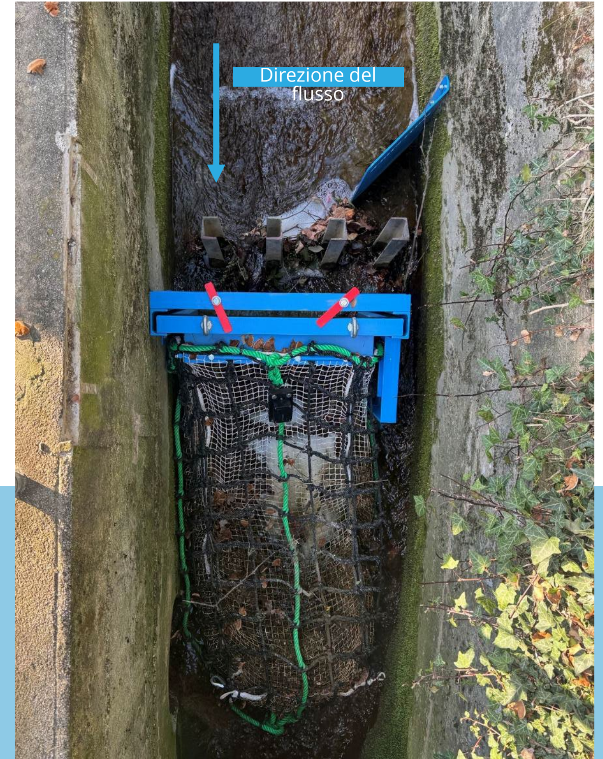
Ritenzione di materiali ingombranti per impedire l'immissione di detriti e l'intasamento della rete idrica sotterranea situata a valle - Lonay, Vaud
